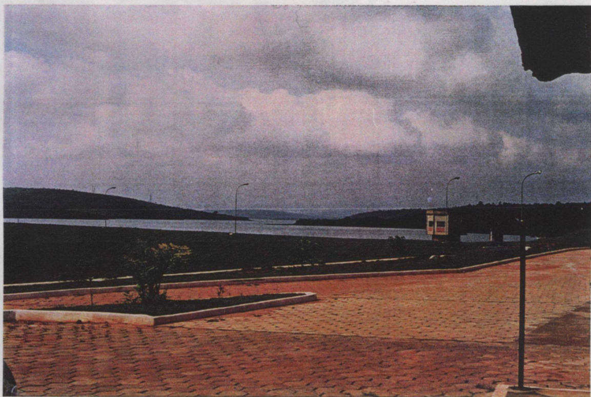
Fotos 3 e 4 - Vistas da barragem construída pela COPASA no Ribeirão Serra Azul, em 1982. À esquerda da Foto 3, pode-se observar o vertedor da barragem e à direita da Foto 4, a tomada d'água.
